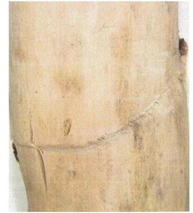
Faciès de rupture en compression
